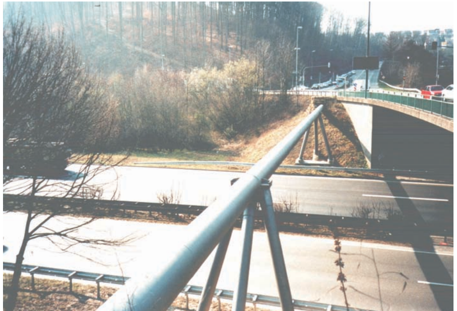
Rohrbrücke über Bundesstraße 10
