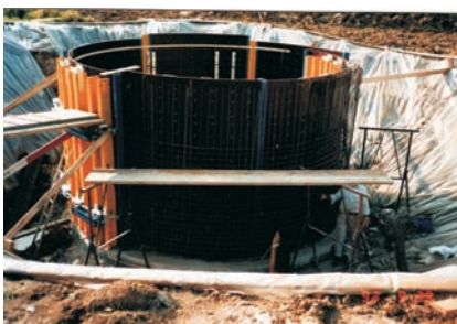
Schalung der Wände
