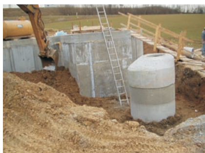
Beckenkörper mit Drossel- und Ablaufschacht
