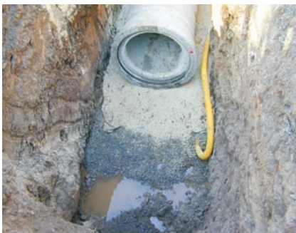
Aufbau der Rohrumhüllung
