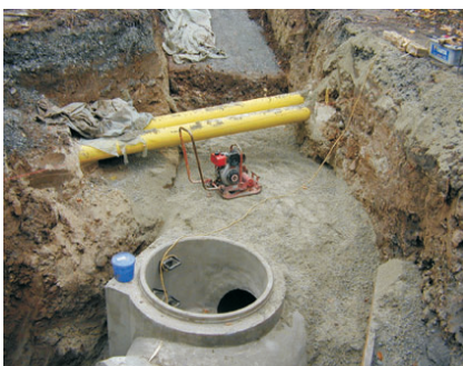
Einbau mineralischer Schachtumhüllung
