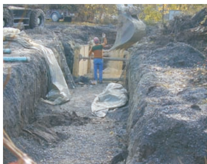
mineralische Verfüllung der Leitungszone
