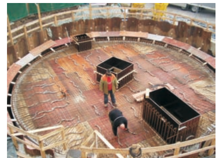
Bewehrung Deckenplatte
