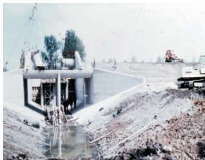
Einlaufbauwerk HRB (Einbau HW-Entlastungsheber)
