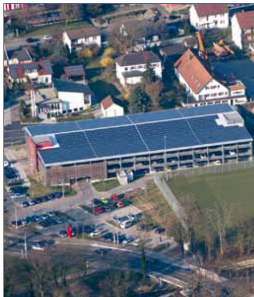
ERNEUERBARE ENERGIEN // Photovoltaik
