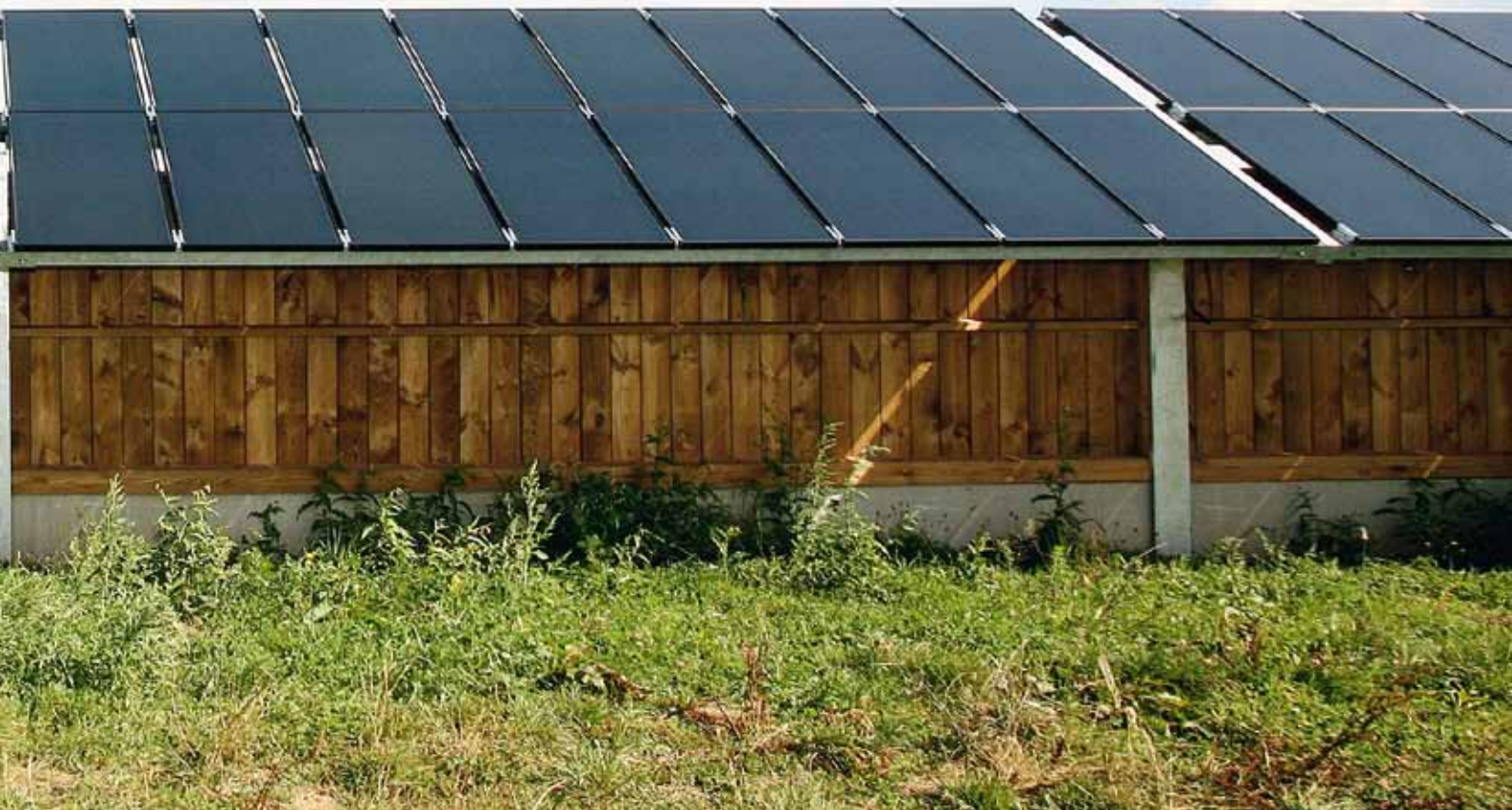
Solare Lärmschutzwand am Reinhold-Würth-Air- port Schwäbisch Hall
